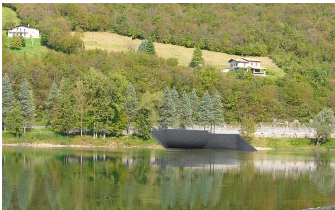
Fig. 12: alternativa con soglia a 367,20 m s.m. di 50,0 m e paratoie all'imbocco della galleria
