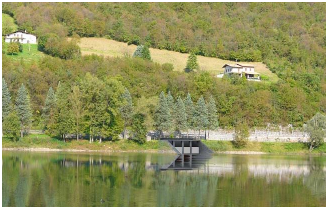
Fig. 11: alternativa con soglia a 367,20 m s.m. di 25,0 m e paratoie sullo stramazzo
