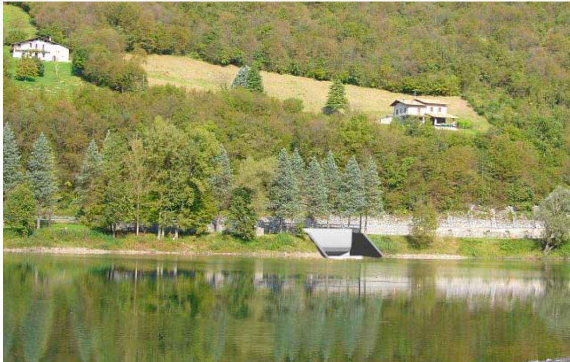
Fig. 10: alternativa con soglia a 367,20 m s.m. di 25,0 m e paratoie all'imbocco della galleria
